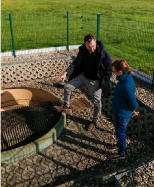
Einblick in die Kläranlage: Unter der Oberfläche dreht sich gemächlich eine große Walze, die das Wasser mit Sauerstoff belebt. Im Bild: Tilo Sahlbach und Katrin Haase
