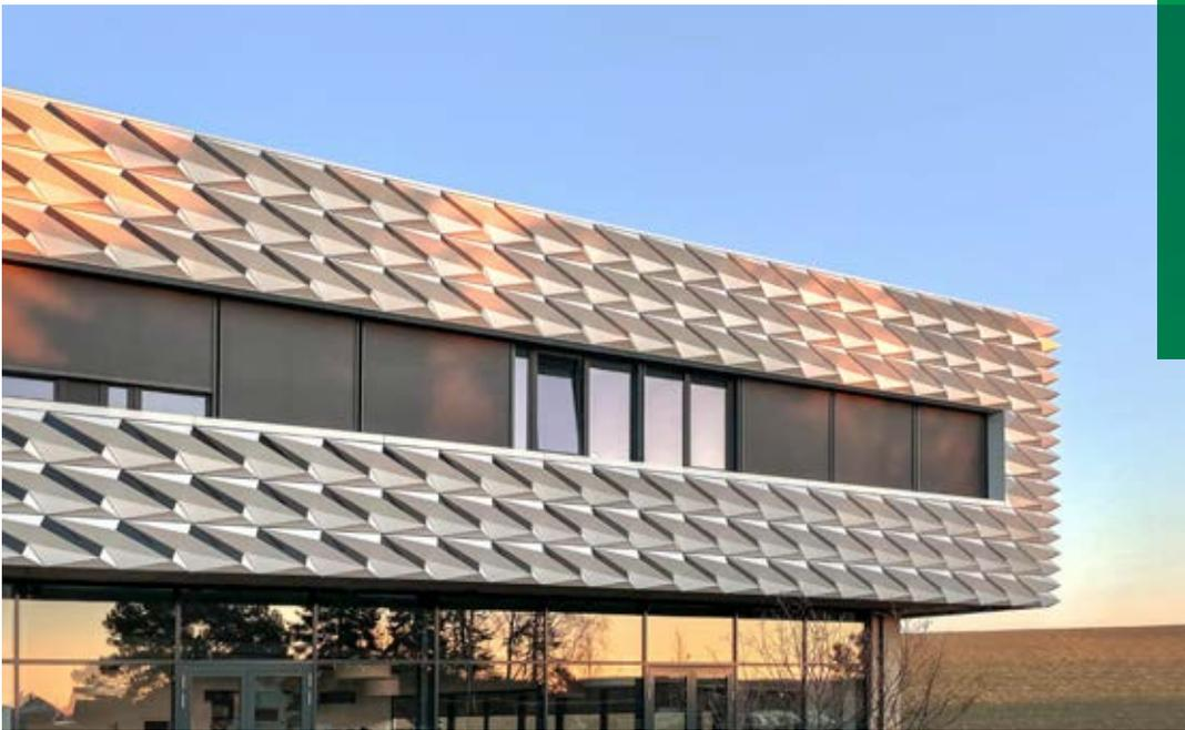
Die Fassade des Firmengebäudes von Aluform produziert dank Photovoltaik 10.000 Kilowattstunden Strom pro Jahr
