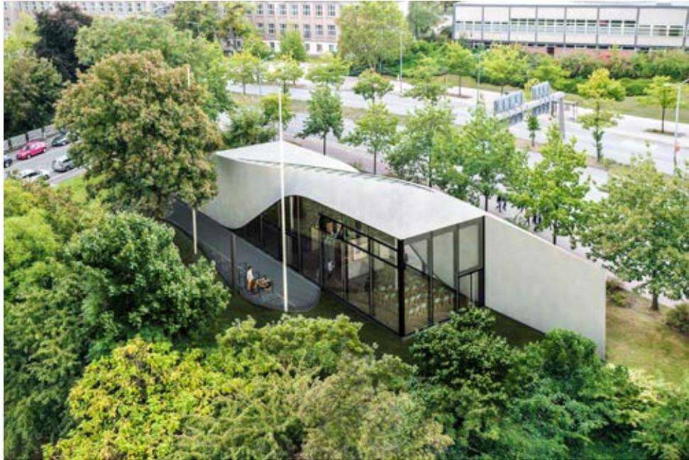
So wird der Cube, das weltweit erste Gebäude aus Carbonbeton, aussehen
